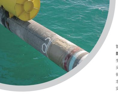
将直管和接头放置好,随后加以焊接,以确保内部管路紧固。接上并焊接好内管后,操作人员可以在**接合部**周边安置HDPE**外罩,灌注**双组分混合物,在原位产生保温聚氨酯层,从而确保适当的**保温连续性**。用于接头部的系统在**预先配置的包装**中出售,进行人工混合。倘若物流方面可行,并且管道的尺寸和直径有相关要求,可以用较大包装供应接头系统,由**便携式发泡设备**实施应用。亨斯迈同时经销上述两种系统。
