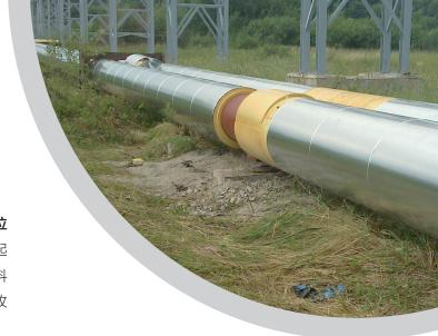
可以使用模制聚氨酯外层或护壳,对管道进行**原位** 保温或**替代**原位接头。两片护壳围绕现有的管道接合起来,随后固定,并用外罩**包裹**,外罩可用多种不同材料 制成,但大多采用金属或玻璃钢。护壳可方便地用于改 造旧式石棉或发泡水泥保温的管道。
